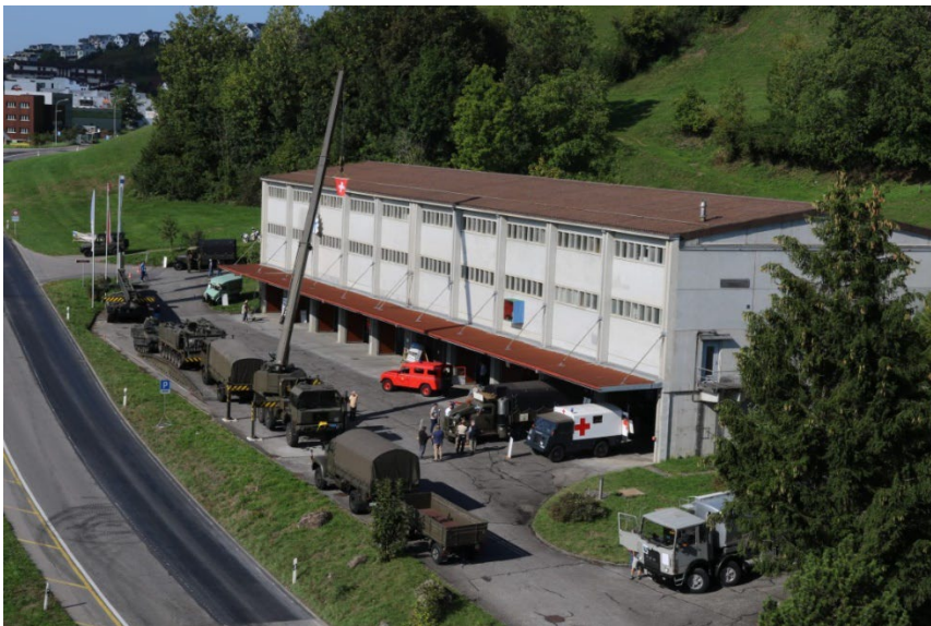
Das Zuger Depot Technikgeschichte in Neuheim. (Bild: Anton Matter)
